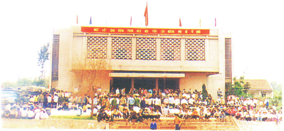
Nhà văn hóa Trung tâm huyện xây dựng năm 1985
